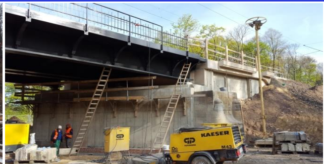
neuer Stahlüberbau inkl. Widerlager
