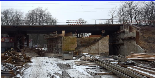
Hilfsbrückenüberbau inkl. WL-Abbrucharbeiten
