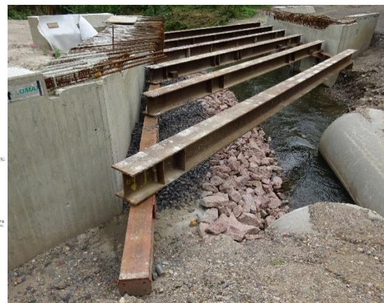
Fertigstellung Widerlager
